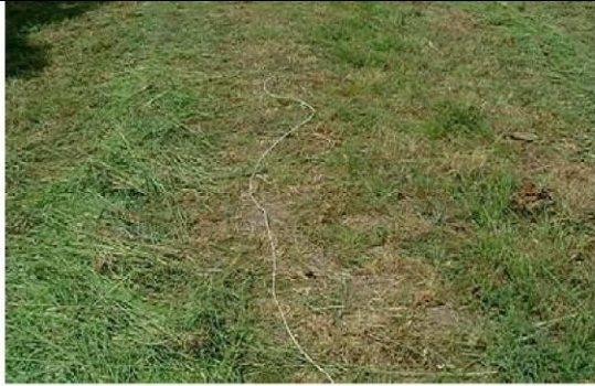
電線の敷設状況
