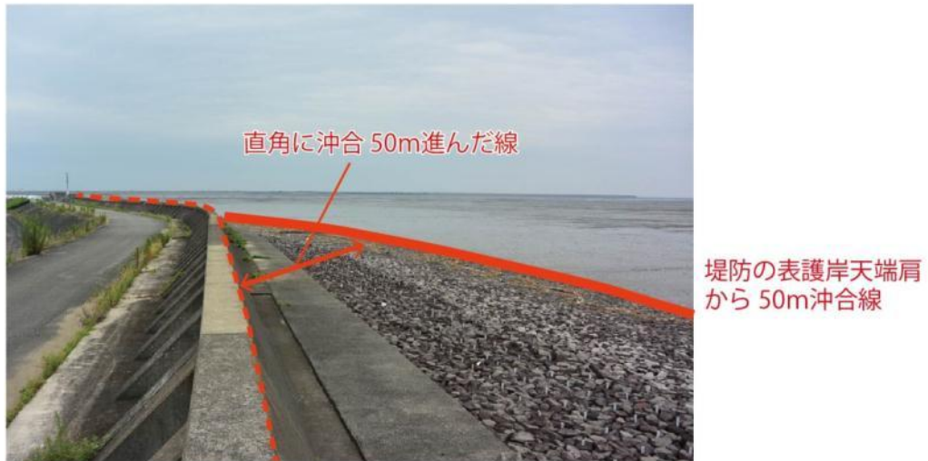
写真 堤防表護岸天端肩から 50m 沖合線
