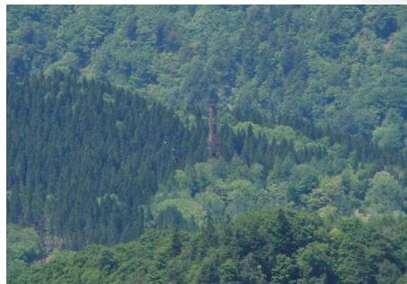
櫓周辺の樹木の残置（国道から撮影）
