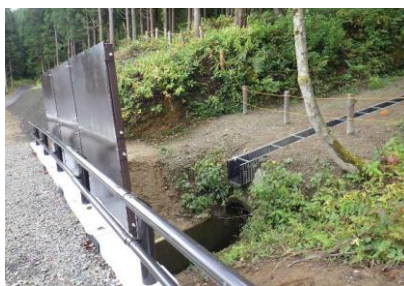
コウモリ類が生息する隧道への遮光版設置
