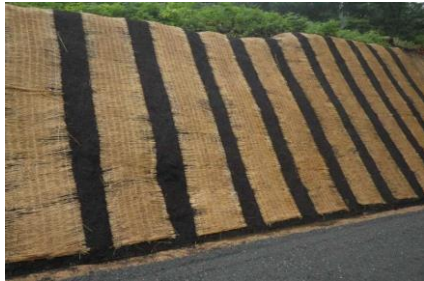
切土法面を植生マット被覆・植生基材吹付（菰張り採用）、木柵設置
