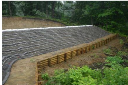
切土法面を植生マット被覆・植生基材吹付（菰張り採用）、木柵設置
