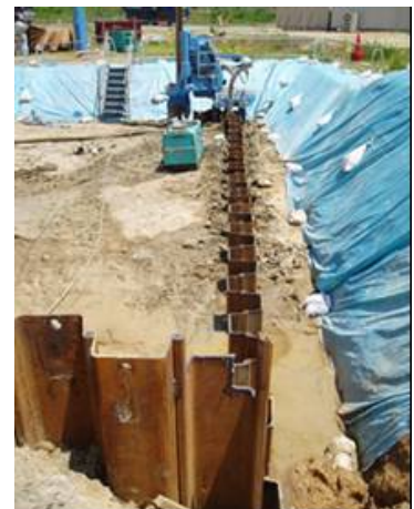
写真3-1 遮水壁(鋼矢板)の打設状況
