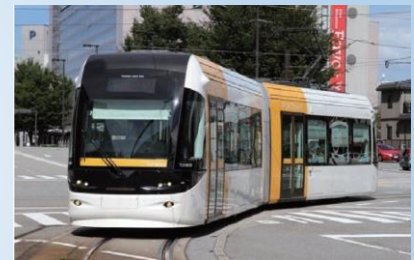
富山ライトレール (環境省HPより)
