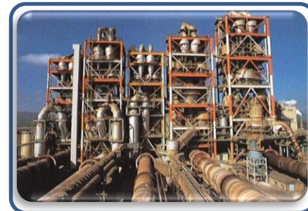
セメント製造施設(21施設)
