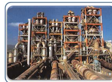
セメント製造施設
