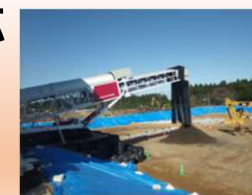
中間貯蔵施設 土壌貯蔵施設
