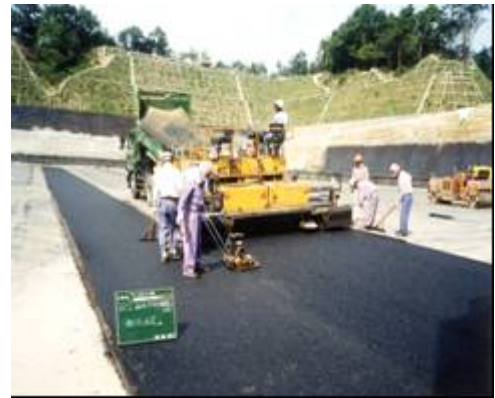
写真2-1 舗装の施工状況
