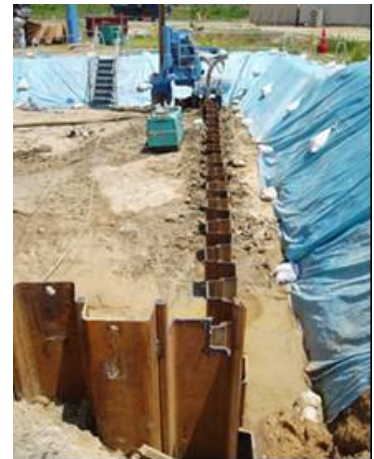
写真3-1 遮水壁(鋼矢板)の打設状況
