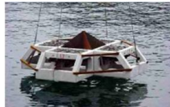
攪拌ブロック礁の設置作業
