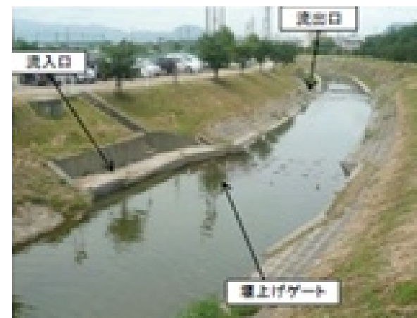
河川浄化施設全景(岡崎川)
