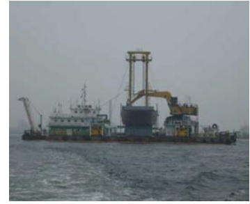
【トレミー船による窪地への土砂投入】
