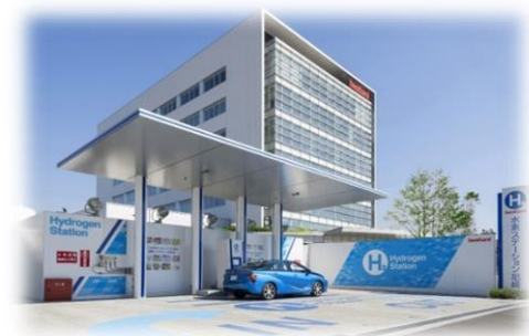
5 水素ステーション（尼崎市）
