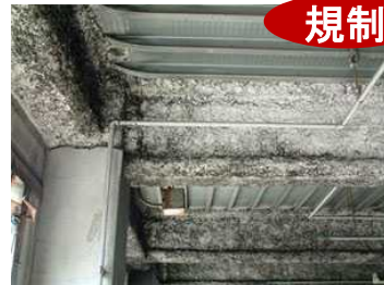
アスベスト含有吹付けロックウール (アスベスト含有率が0.1%を超えるもの)
