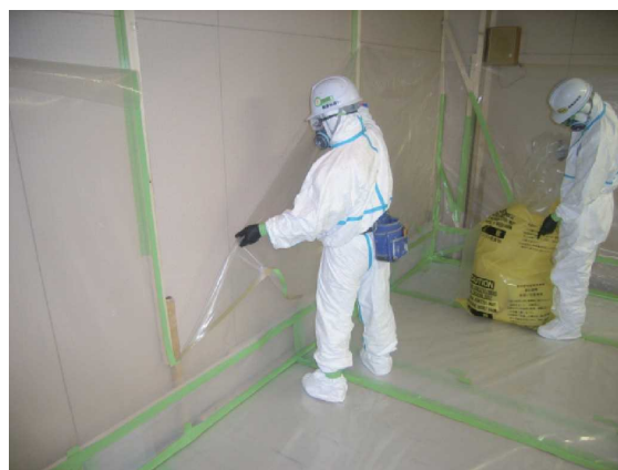
図 3. 72 養生シートの撤去
