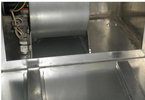
図 3.26 フレームと本体の接合部の隙間のコーキング場所
