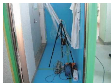
図 3. 18 同左施工区画(内部)
