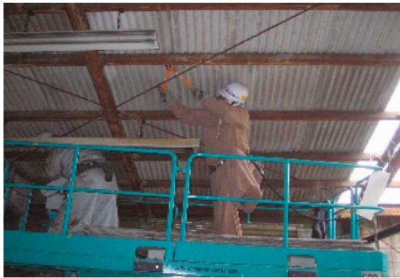
屋根スレート止め金物切断
