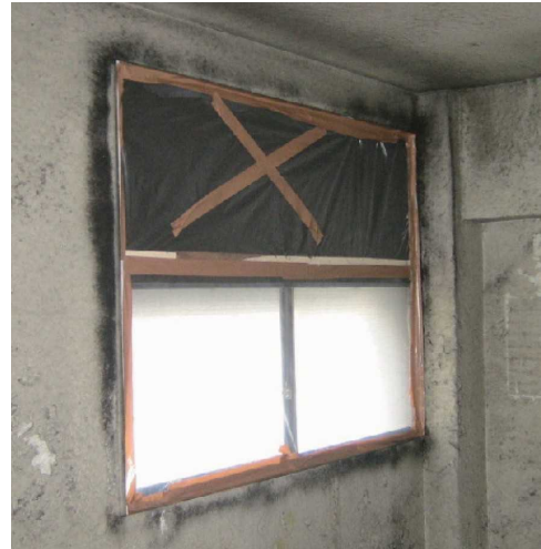
図 3. 27 窓、換気口の養生例
