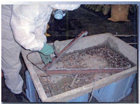
図 3. 118 掻き落とし除去作業の例
