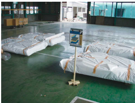
図 3. 116 石綿含有成形板廃棄物の保管例
