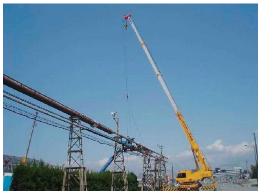
図 3.90 配管吊り降ろし
