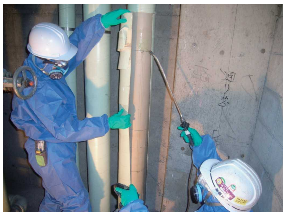
図 3.80 保温材の取外し
