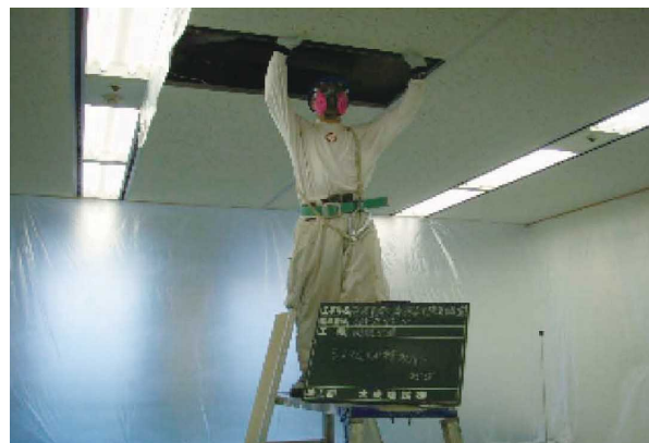
図 3.110 天井石綿含有成形板の除去例
