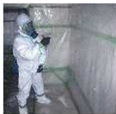
図 3.28 養生シートへの散布
