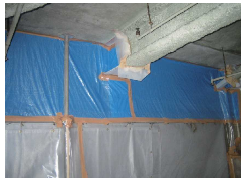
図 3.25 壁面の隔離養生例（作業場内側）
