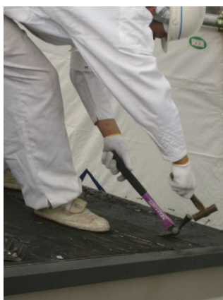
接合固定部分の取外し
