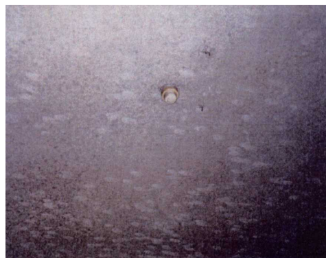
（吸音・断熱材：機械室の壁・天井）
