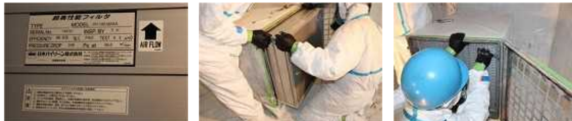
図 3.41 フィルタの取り付け
