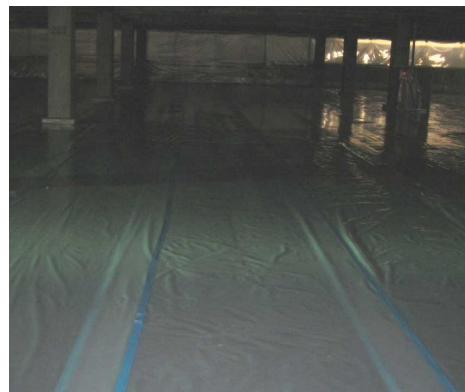
図 3.24 床面の隔離養生例（2重張り）
