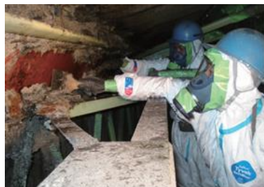
吹付け石綿の除去作業
