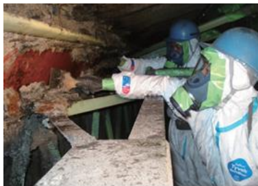
吹付け石綿の除去作業
