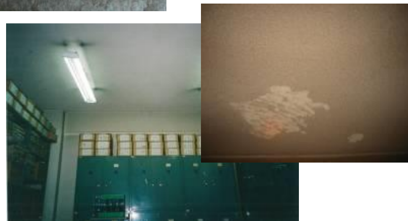
浴室・階段室・金庫室・書庫 ・集合住宅居室等の天井
