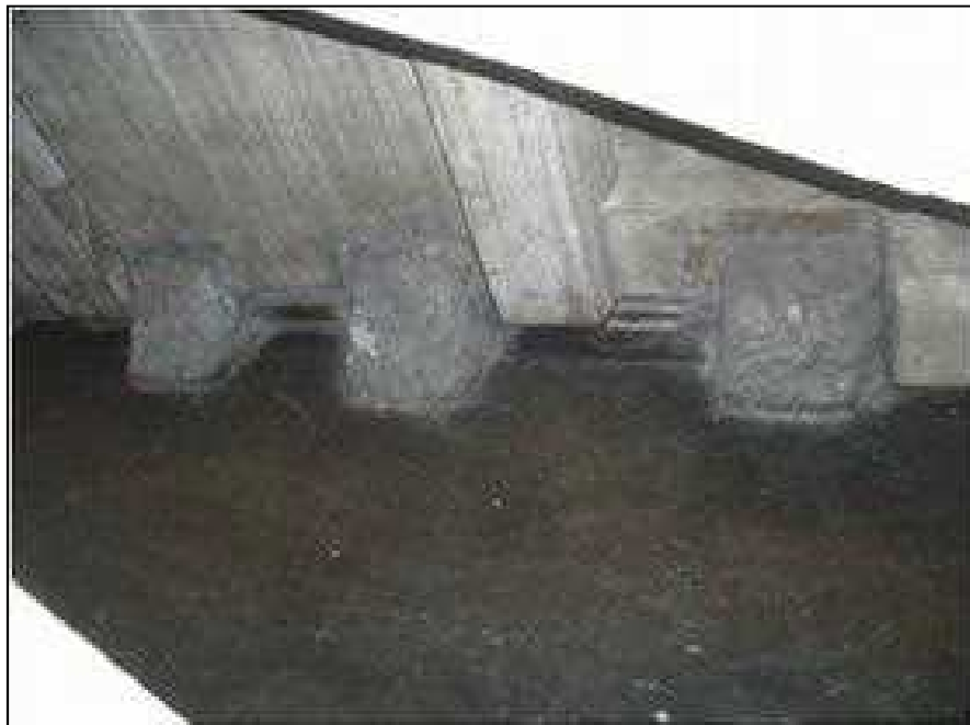
写真 4-3 外壁 外壁カーテンウォールファスナー部の 吹付け石綿による耐火被覆例
