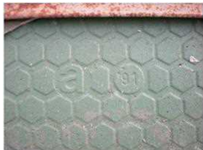
写真 4-5 ボード類 取り外し、解体などを行って ボード類の裏側を見る
