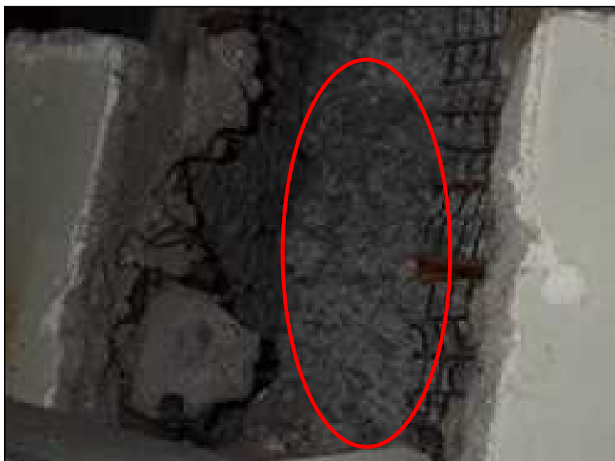
写真 4-1 柱 柱のラスモルタルの裏に吹付け石綿があった例
