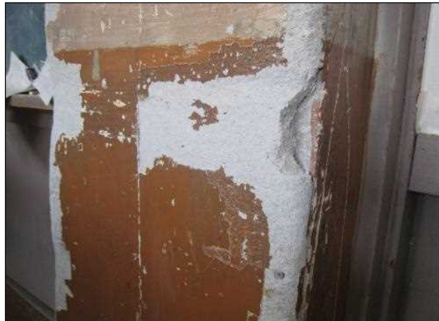
写真 4-4 柱 柱の耐火被覆板にそのまま仕上げを行なった例
