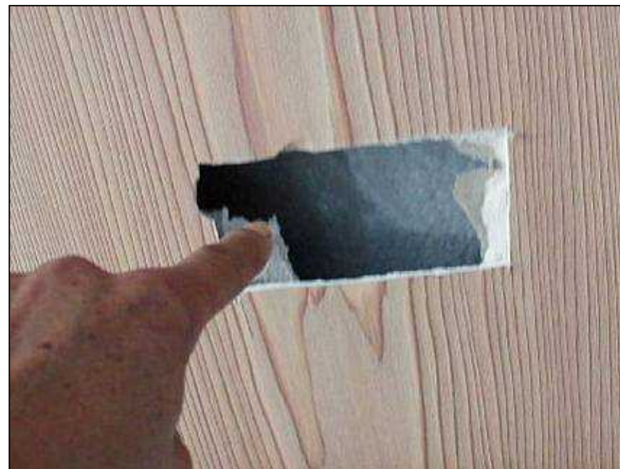
写真 1-2 共同住宅最上階 天井ボードの裏の吹付け材の例
