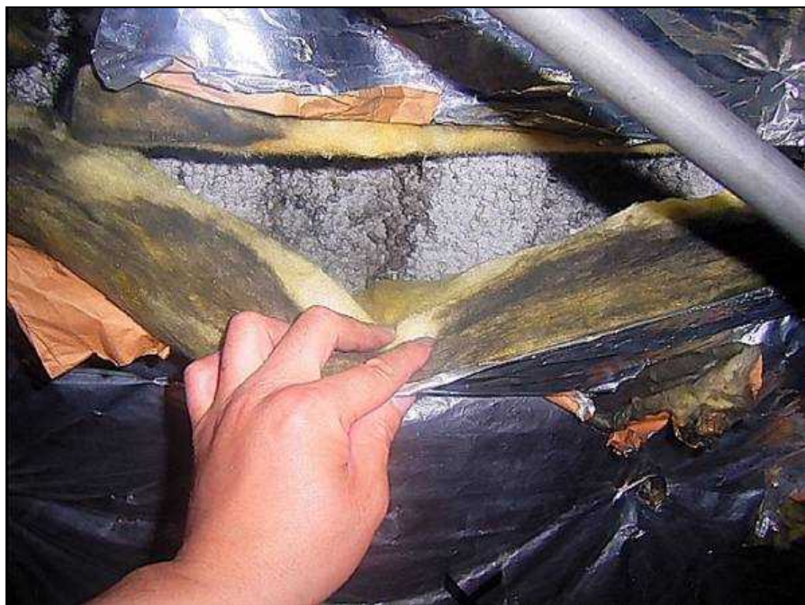
写真 1-1 内装仕上げ材の下に 吹付け材が存在する例
