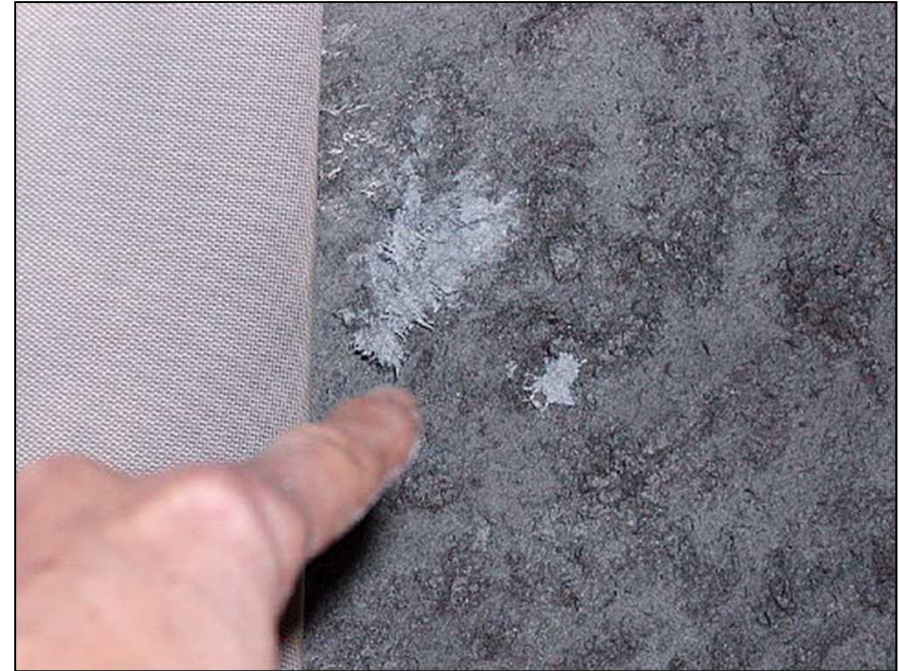
写真 1-4 機械室 左のガラスクロス下の吹付け材の例
