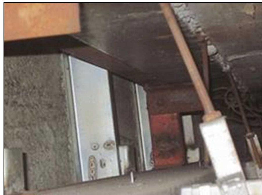
写真 4-2 外壁(室内天井内) 外壁(PCカーテンウォール)裏に 吹付け石綿があった例
