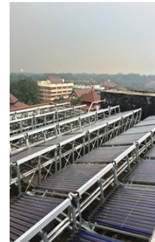
設置された集熱器
