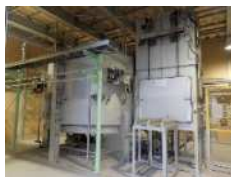
<Li-ion電池リサイクル設備>
