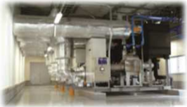
<中央方式冷凍冷蔵機器>
