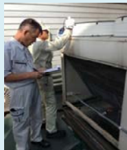
機器外観の検査
