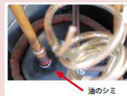
配管継ぎ手からの油染み
