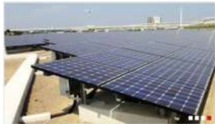
廃棄物埋立処分地におけるメガソーラー
