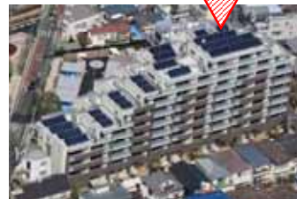
(写真提供 大和ハウス工業株式会社)
