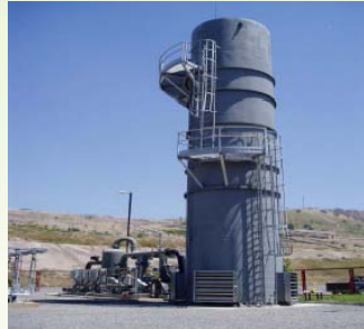
ごみ埋め立て場メタン回収 燃焼CDM (チリ)
