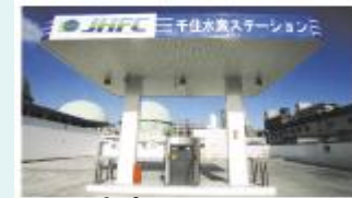
水素ステーション
