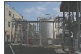
BDF製造設備
