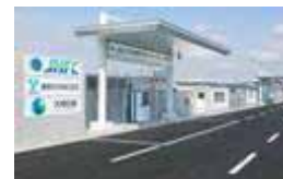
水素ステーション
