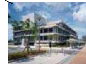
須崎第2合同庁舎(高知県)
