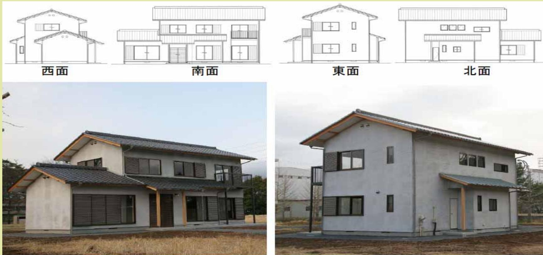
1980年頃の木造住宅を再現し、断熱改修の研究を行う(国総研)。住宅においては、ストックが4700万戸、フローが120万戸/年なので、断熱改修や高効率機器への変更などのストック対策が必須である。
