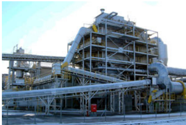
図表 19 能代森林資源利用協同組合のバイオマス発電施設
