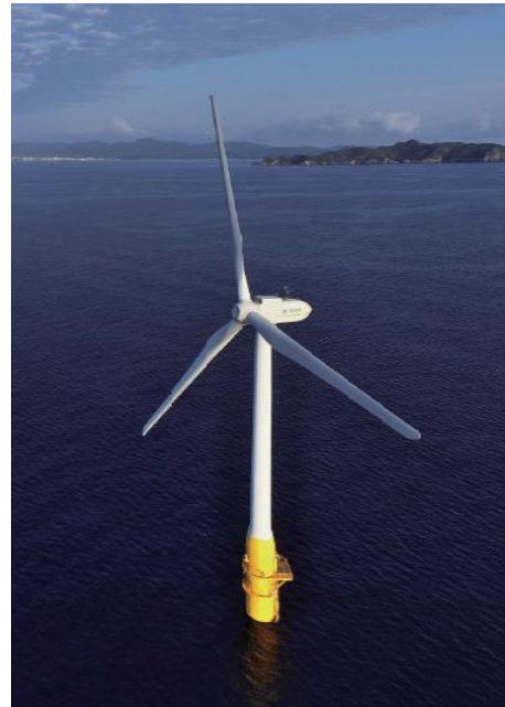
浮体式洋上風車
