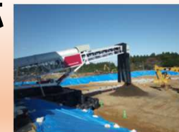
中間貯蔵施設 土壌貯蔵施設
