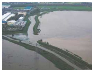
洪水被害 写真提供：国土交通省中部地方整備局
