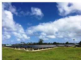
無償資金協力により導入された太陽光パネル(トンガ)
