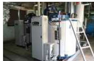
【BEMS開発によるホテル省エネ】 (ベトナム) 高効率機器(ボイラ、ヒートポンプ、LED照明)及びベトナム仕様のBEMSをホテルに導入し、ビル全体の省エネ化を実証。想定削減量605tCO 2 /年。2017年1月稼働予定。
