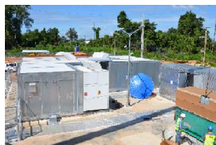
【省エネ型データセンター】 (ラオス) 高温多湿のラオスの環境下においても稼働可能な高品質・省エネのデータサーバーを導入し、省エネ性能を実証。想定削減量1,074tCO 2 /年。2017年1月稼働予定。
