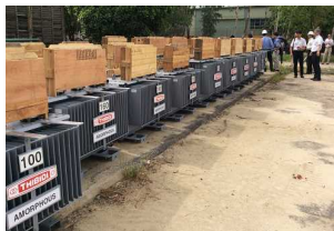
【高効率アモルファス変圧器】 (ベトナム) 無負荷損失が大幅に低減する変圧器を南部・中部の配電網に導入。想定削減量4,360tCO 2 /年。2017年2月稼働予定。
