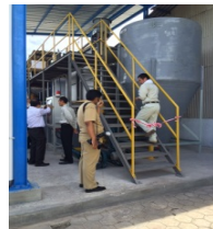
インドネシアのコベネフィット技術実証施設
