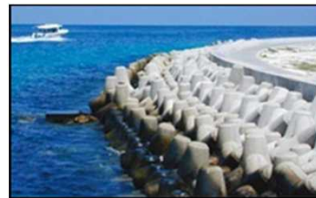
護岸壁の建設支援
