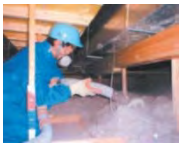
天井の断熱改修
