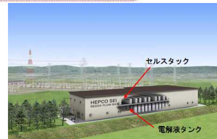
北海道の変電所に設置する大型蓄電池イメージ
