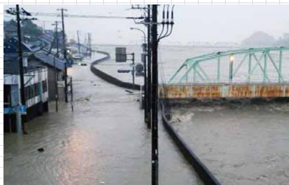
2011年台風第12号による熊野川(三重県南牟婁郡紀宝町)の越水状況
