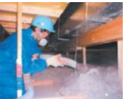
天井の断熱改修
