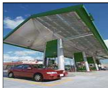
バイオエタノール混合 ガソリン(E3等)製造設備
