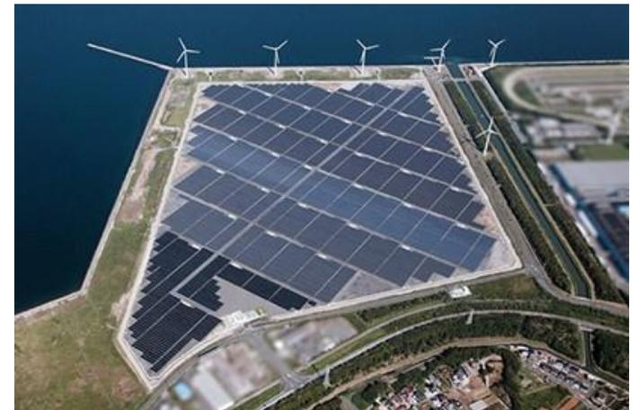
注) 太陽光 50MW（パワーコンディショナー35MW）、風力発電 2MW×3基
