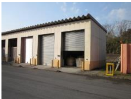
写真 2.4.1 保管庫の外観の例
