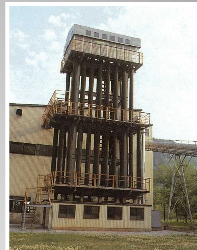
コンデンサータワー
