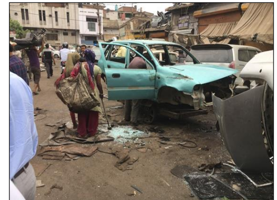
図4. インドの解体の様子
