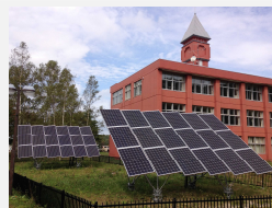
避難所に設置した太陽光発電
