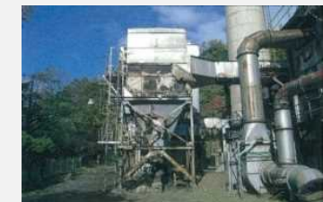
老朽化した廃棄物処理施設の更新
