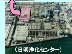
(日明浄化センター)
