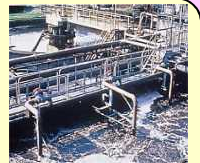
排水処理装置
