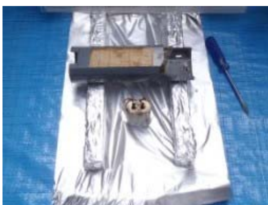
コンデンサ取り外し作業終了
