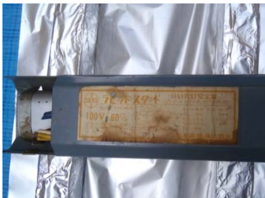
コンデンサ外付け型安定器
