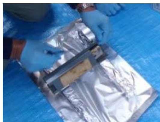
コンデンサ取り外し作業中
